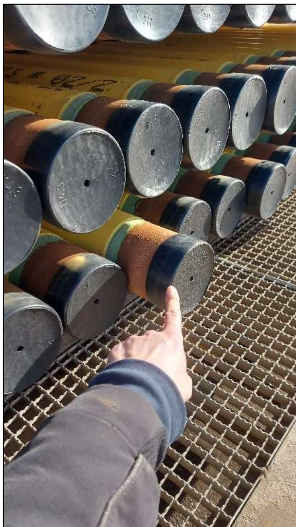
Abbildung 17, in Versuch 1.12 festgestellte Verschiebung eines Rohres um ca. 8 cm nach Überfahren von Bahnschienen.
